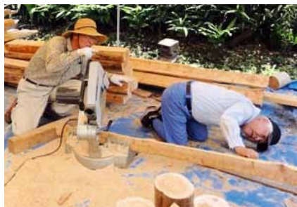
東屋に刻みを入れる作業
