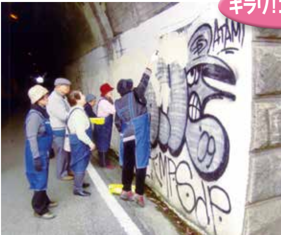
危険が伴う、トンネル内の落書き消し
