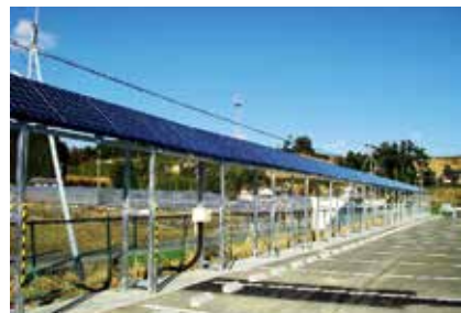
▲10Kw、全長72m、56枚のパネルが並ぶ
