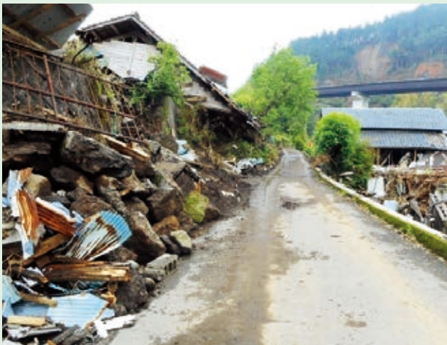
西原村大切畑地区の被災状況
